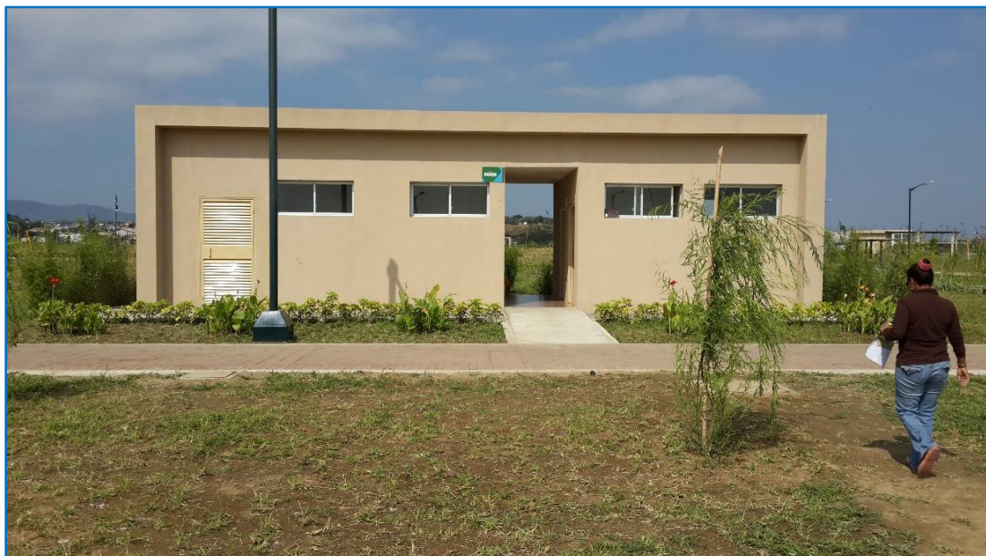
Ilustración 9. Exterior del área de baterías sanitarias
